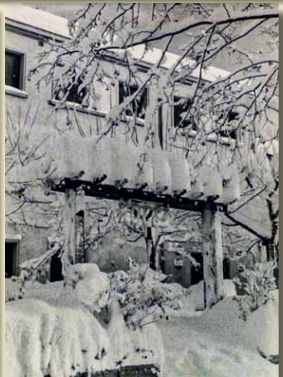
Portalada d'entrada a l'Hotel de Vallgorguina
